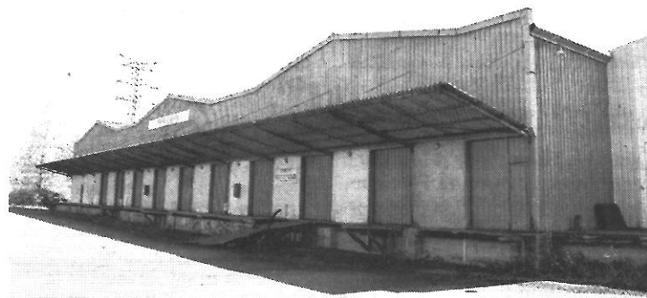
Les anciens locaux de Mory, au 250, boulevard De-Gaulle, à Saint-Cyr, seraient démolis et remplacés par la halle de marché.
